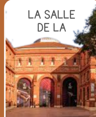
LA SALLE DE LA HALLE AUX GRAINS
